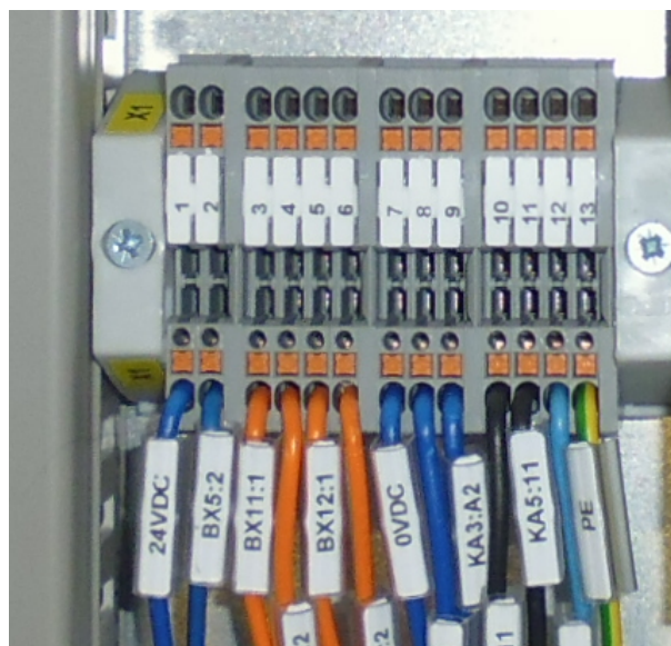
Obr.11 Připojovací svorky signálů
