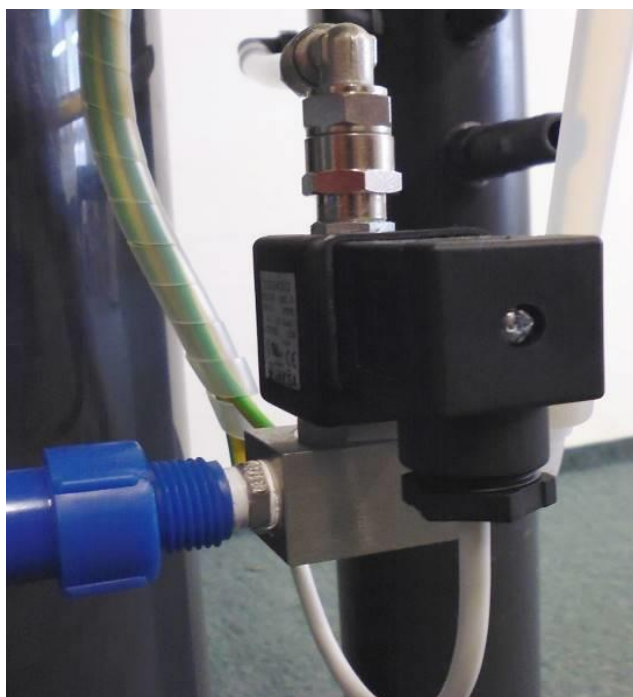
Obr.8 Výměna elektromagnetického ventilu O3
